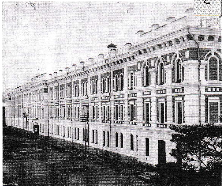
↑旅順工科大学本館（明治43年～昭和20年）、現在は中国海軍病院。
