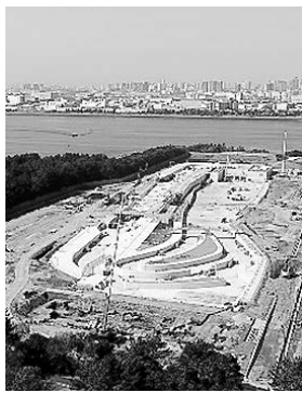
注水前のカヌースラローム会場
